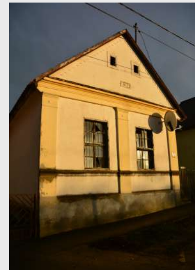
Vakolatdíszes oromzat keretelt téglány padláslyukkal és évszámmal. A homlokzatot az oromfal alján övpárkány, a nyolcosztatú faablakok alatt egyszerűbb könnyöklőpárkány tagolja. A két ablak arányai az egyszerű fejezetű lizénák által közrefogott falmezők arányait követik. A homlokzat tükörszimmetrikus.
