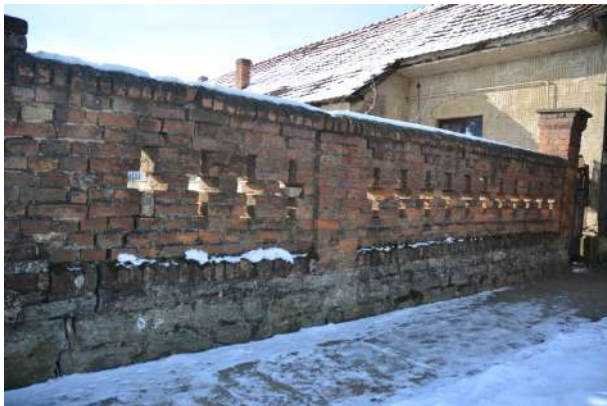
Még látható az íves idomtégla zárósora
