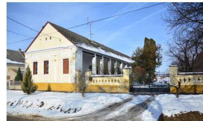
437 hrsz.: lakó- és gazdasági épület, kerítés (a kerítés a településen az egyetlen, mely igazodik az építéskori színezési hagyományhoz)
